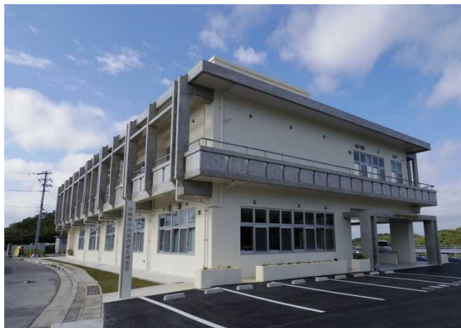
新庁舎が平成26年9月に完成
