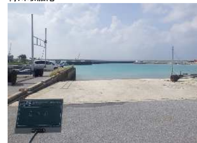
改良前の船揚場
