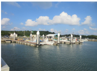
改良後(浮棧橋)
