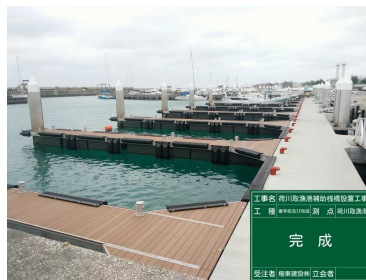
改良後(浮棧橋)
