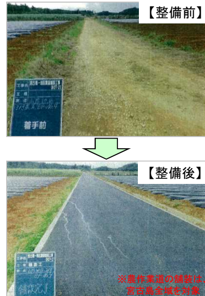
【農作業道 舗装】
