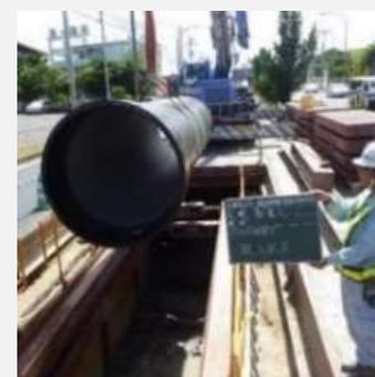
➤石川浄水場（うるま市）から上間調整池（那覇市）までの基幹管路（管径φ1350mm）
