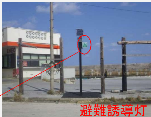
避難誘導標識
