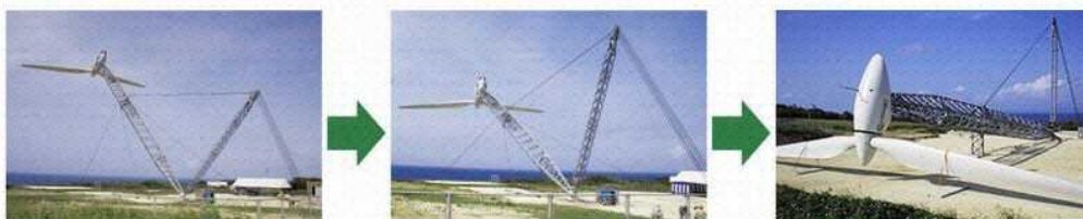
波照間可倒式風力発電設備（傾倒時）
