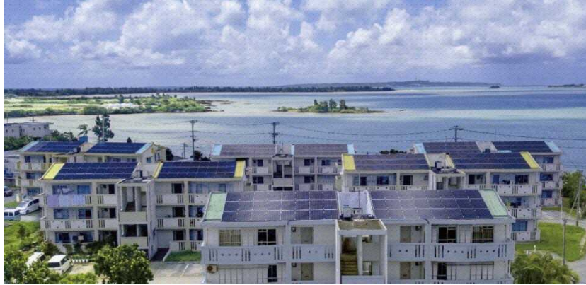
ソーラーパネルを設置した市営住宅外観
