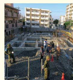
那覇市内の住宅地で建物の下に埋まっていた旧日本軍製60kg爆弾2発が発見された建設工事現場（平成30年12月）
