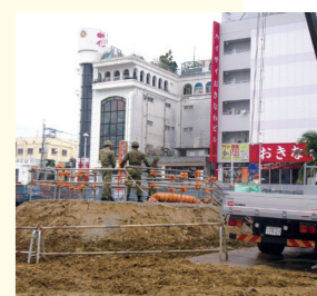
那覇市内の国際通り沿いで建物の下に埋まっていた米軍製50kg爆弾が発見された建設工事現場（平成30年1月）
