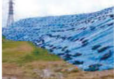
工事現場の対策 (シート被覆)
