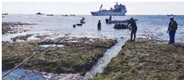
海底光ケーブルを敷設船から引揚げる作業（八重瀬町）
