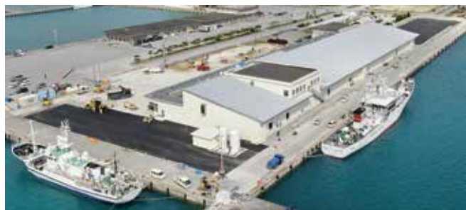
荷捌施設の全景（撮影日：令和4年2月24日）
