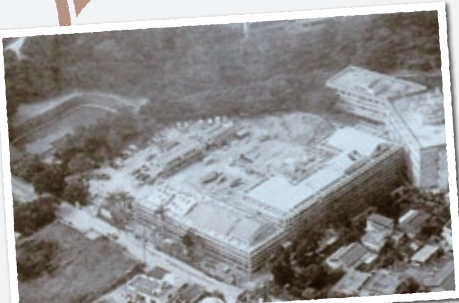
建設中の沖縄県立芸術大学 沖縄県立芸術大学提供
