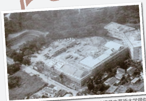
建設中の沖縄県立芸術大学
