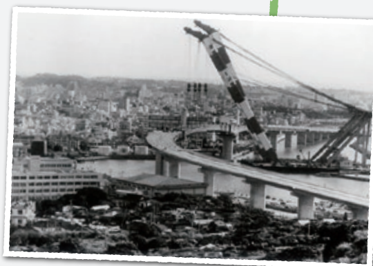
架橋工事中の泊大橋
