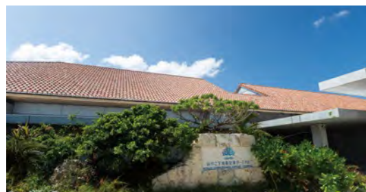
宫古下地岛机场航站楼
