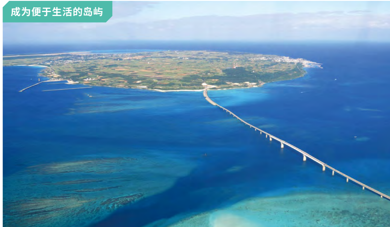
连接宫古岛与伊良部岛的伊良部大桥
