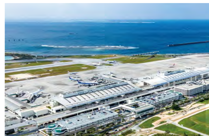
修整作为临空据点的那霸机场 照片提供：那霸机场 BUILDING 股份有限公司
