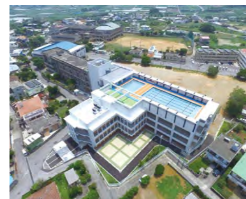
修整公立学校设施
