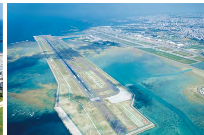
那霸机场 第二滑行道 照片提供：内阁府 冲绳综合事务局
