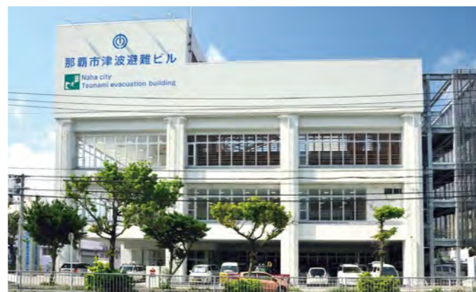
那霸市海啸避难楼
