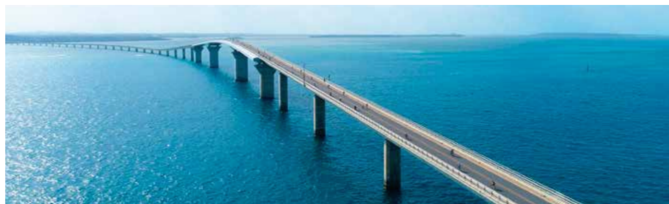
伊良部大橋(© OCVB)
