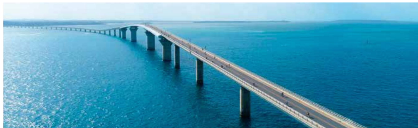
伊良部大橋(©OCVB)
