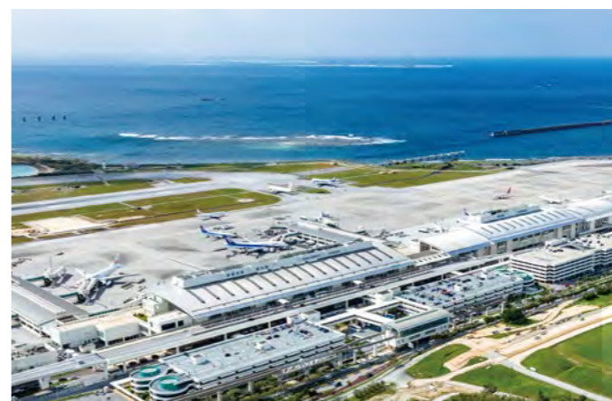
正進行臨空據點建構作業的那霸機場 照片提供：那霸機場 BUILDING 股份有限公司
