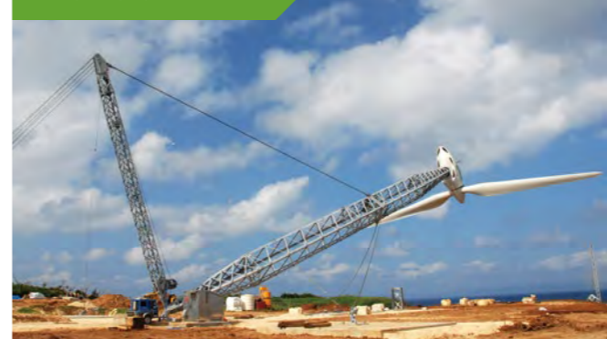
遇颱風時結構體可傾倒的可傾式風力發電 照片提供:沖繩電力株式會社
