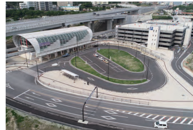
てだこ浦西駅及びパークアンドライド駐車場
