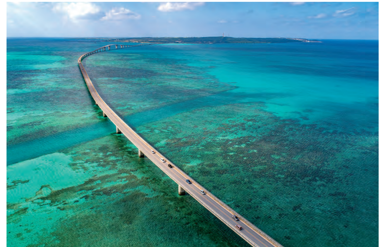
通行料金が無料の橋としては、日本最長(全長3,540m)を誇る伊良部大橋。2015(H27)年供用開始。
