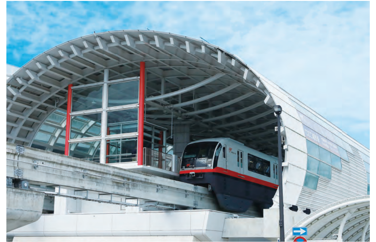
沖縄都市モノレール(ゆいレール)は2019(R1)年に4駅延長し、観光や県民の足としてさらに利便性がアップ。
