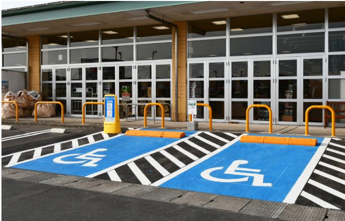
床面を青色に塗装した事例
