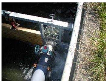
取水堰の水圧管取付け部
