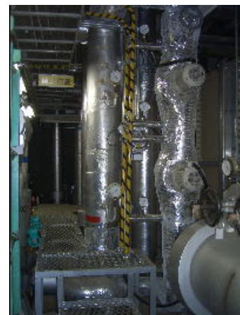
水車発電機(2台直列) 空調用冷却配管に設置
