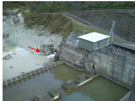
放流口(下久保第二発電所)
