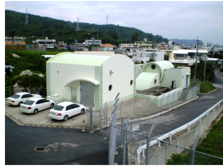
西原浄水場小水力発電機棟 全景
