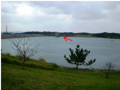
倉敷ダム (矢印：取水設備)
