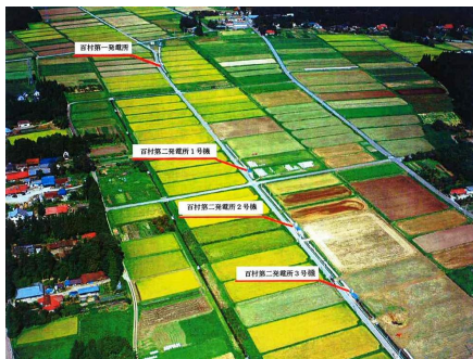
農業用水路に設置した 4 基の発電所全景 (百村第一、第二発電所)
