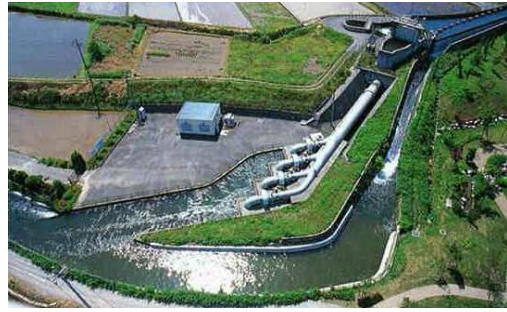
天狗岩発電所全景
