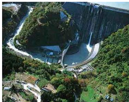
下久保ダム全景
