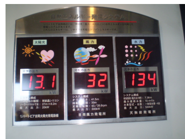
自然エネルギー発電の案内板 天狗岩発電所、吉岡風力発電所 リバートピア吉岡太陽光発電設備
