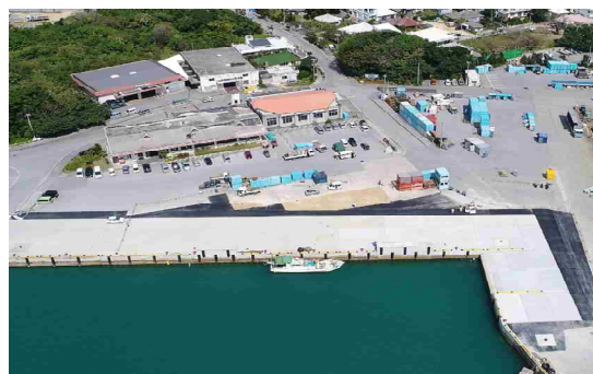
離島港湾 久米島(兼城港兼城地区)
