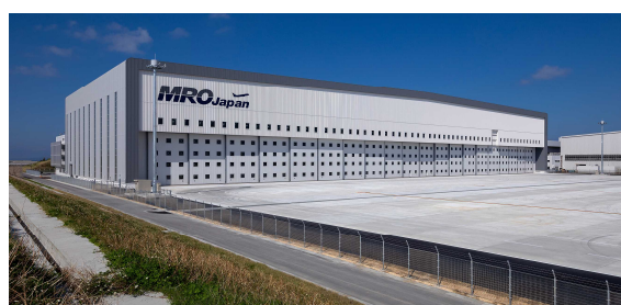
航空機整備施設
