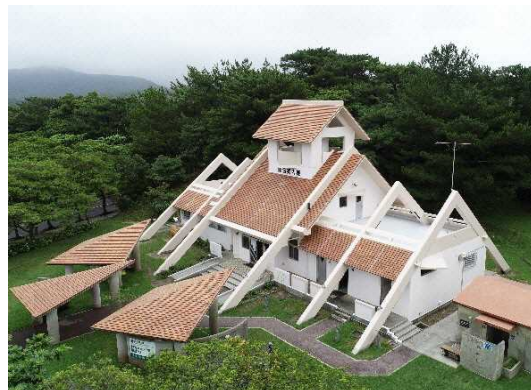
（施工後）防水・外壁・設備改修
