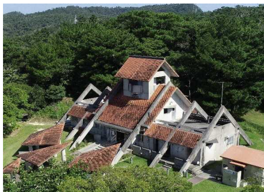
（施工前）老朽化した建築物
