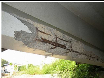
県内の塩害による損傷事例写真（インフラ系 左側：橋梁 右側：海岸護岸）
