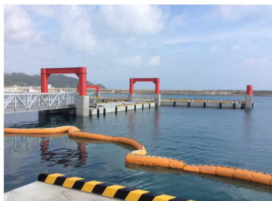
（施工後）浮棧橋の杭を除く全体改修
