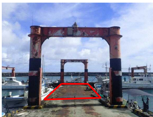
（施工前）老朽化した浮棧橋
