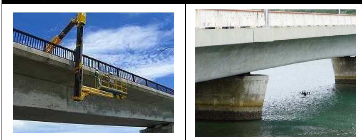
点検状況写真 16 (左側:橋梁点検車による橋梁点検 右側:ドローンによる橋梁点検)
