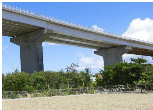
（施工後）鈹桁部の塗装塗替え
