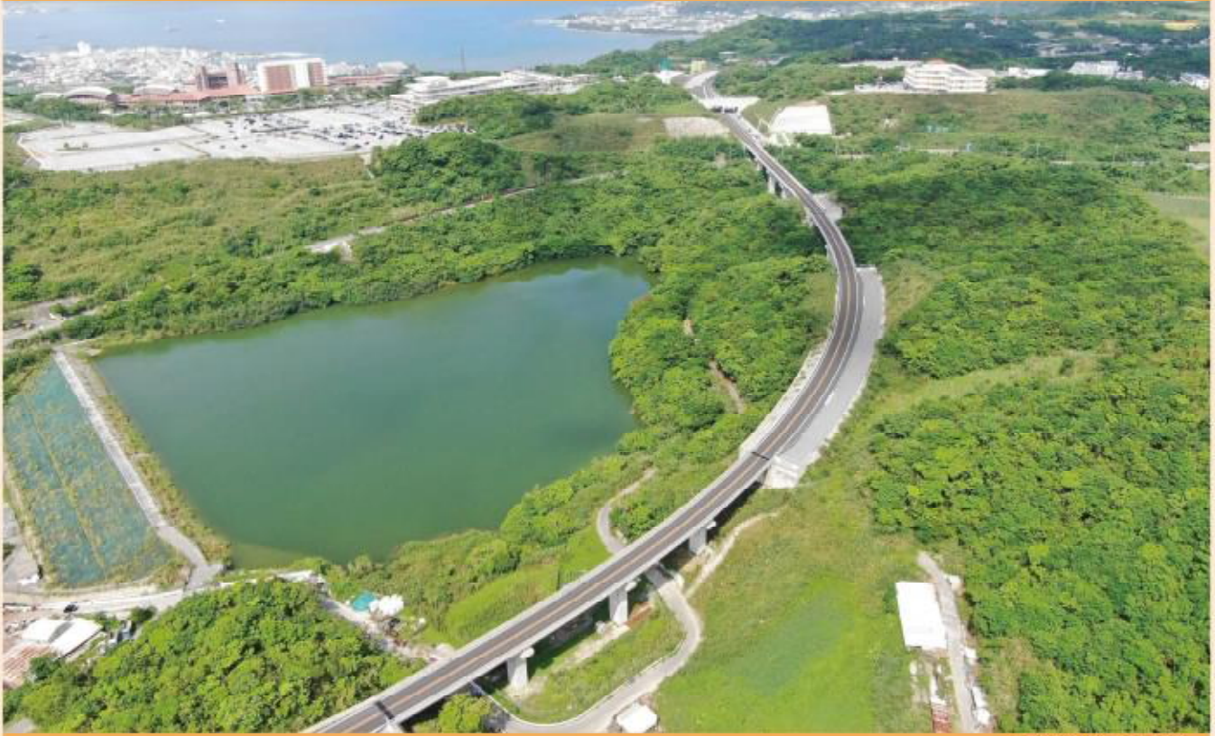
南部東道路（南城市）
