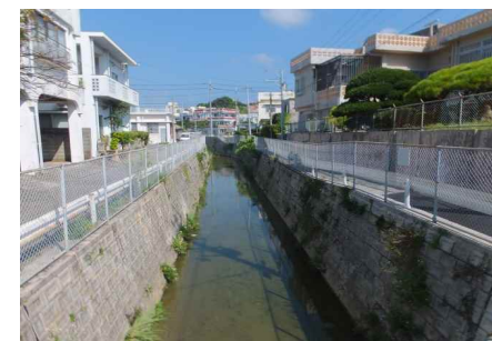
平成24年に2級河川の指定を受けた国道330号より上流部の未整備箇所。
