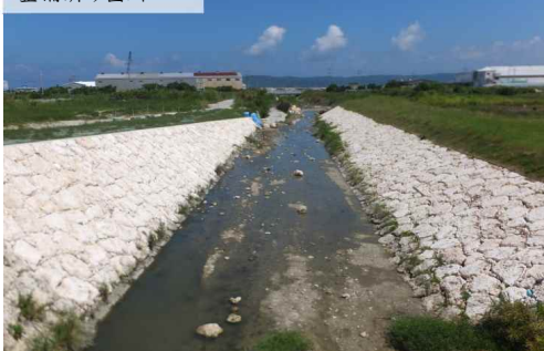
整備済み箇所
