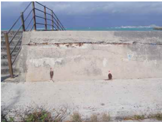
鉄筋の腐食
