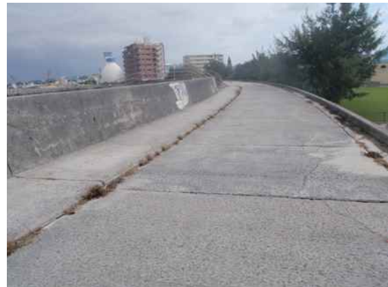
天端被覆工の事例
