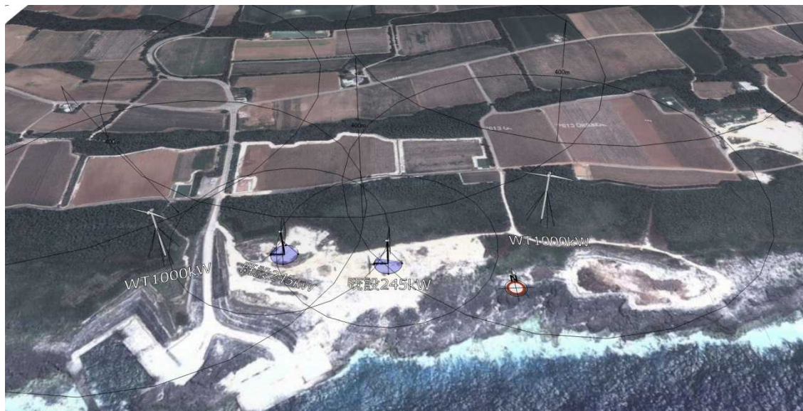
昇降式風車 GEV-HP 1000kW
