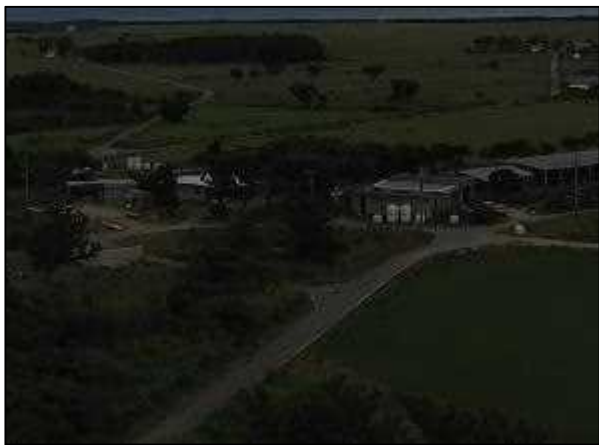
写真㊩ 高圧線ルート 2
