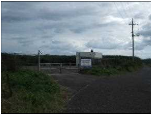
写真③ 焼却施設
