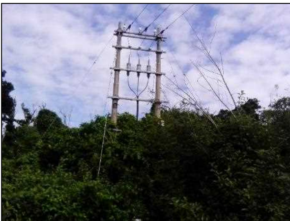
写真⑨ 海底ケーブル立ち上がり
