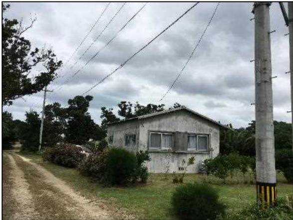
写真⑦ 高圧線ルート 4
