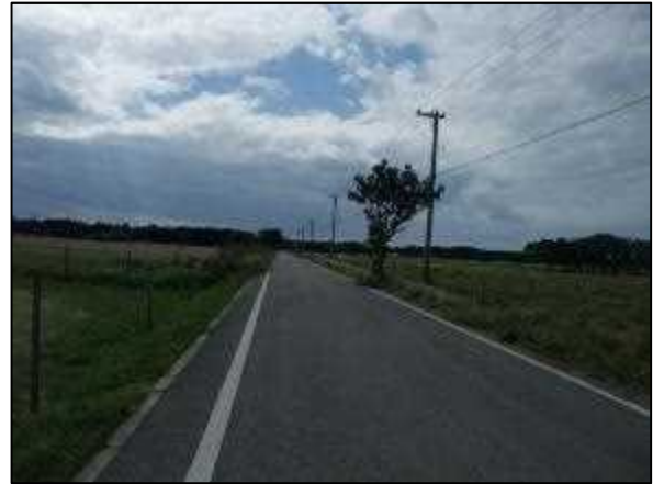
写真⑳ 高圧線ルート 10
