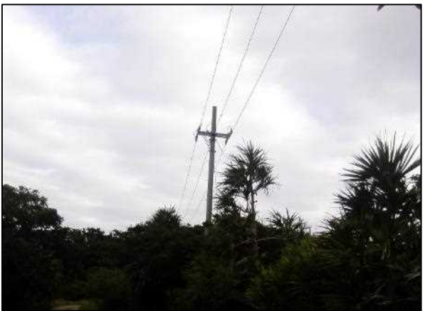
写真⑤ 高圧線ルート 2
