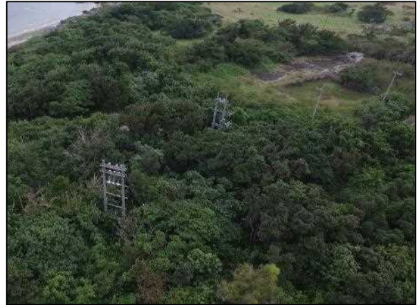
写真② 海底ケーブル埋設部
