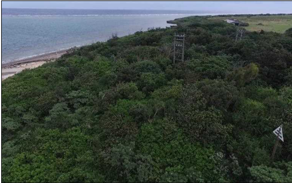
d. 送電埋設部(新城島(下地島)—新城島(上地島))
