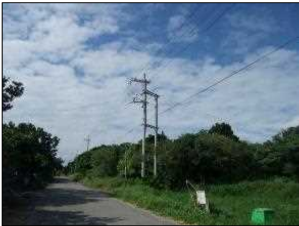
写真㉓ 高圧線分岐 3
