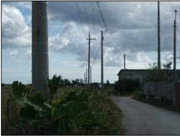
写真⑦ 高圧線ルート3
