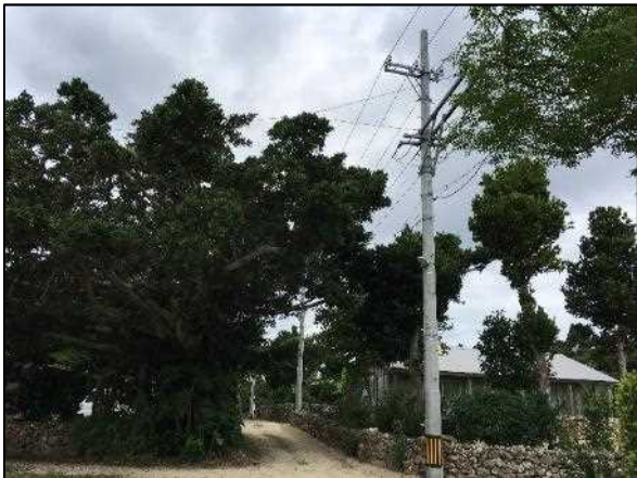
写真⑨ 高圧線ルート 6
