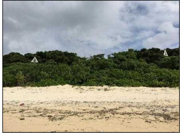
写真② 海底ケーブル立ち上がり
