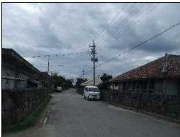
写真㊪ 高圧線ルート 3
