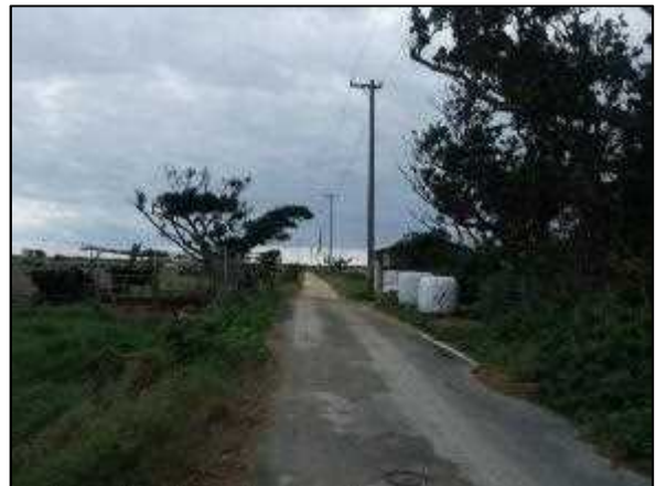
写真⑭ 高圧線分岐後ルート 2
