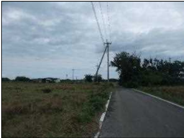
写真⑬ 高圧線ルート 4
