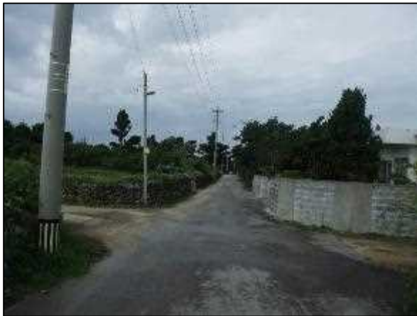
写真㊨ 高圧線ルート 1
