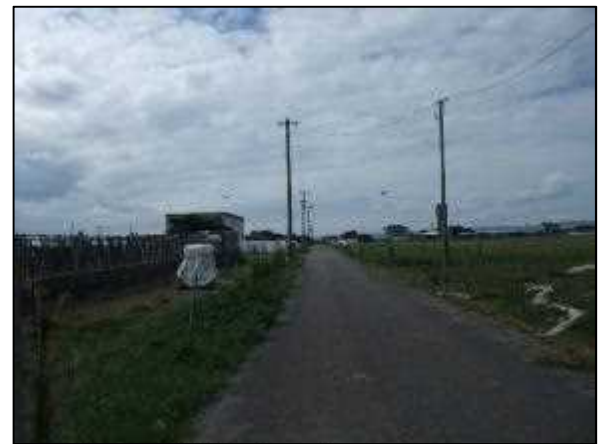
写真⑱ 高圧線ルート 8
