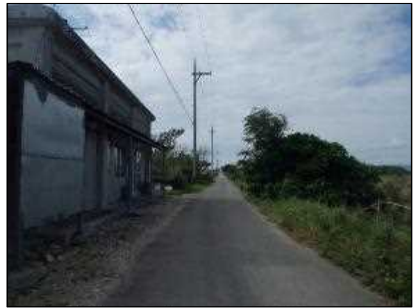
写真⑯ 高圧線ルート 6
