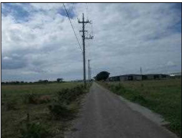
写真⑰ 高圧線ルート 7
