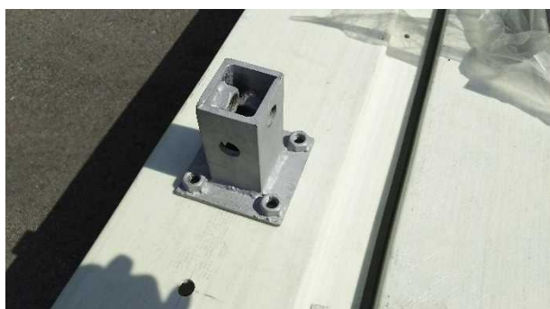
架台コンテナ固定金具
