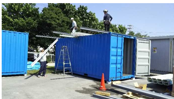
架台組立状況①
