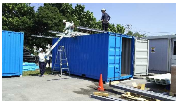
架台組立状況②
