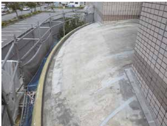
2階エントランス屋上（施工前）
