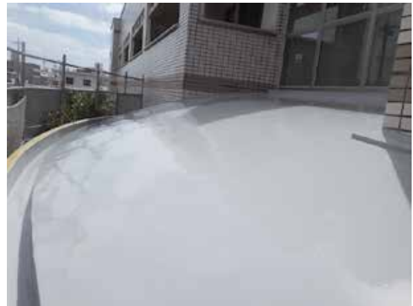
2階エントランス屋上（施工後）
