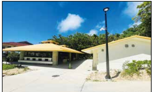
トイレ・シャワー棟 / 炊飯棟（外観）
