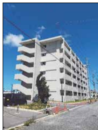
市道側敷地内歩道状況
