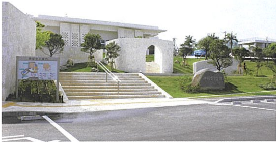
施設・導入空間（アプローチ）
