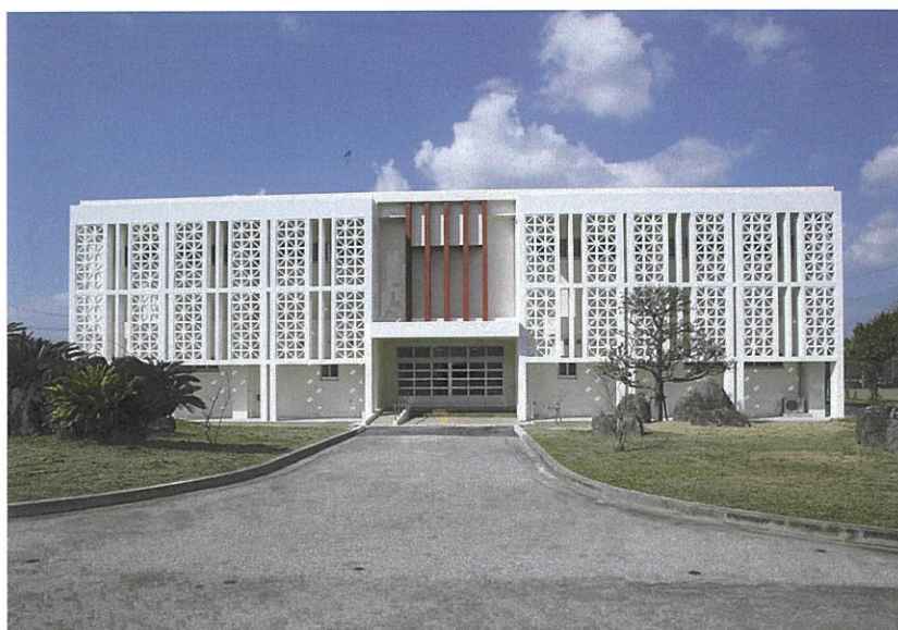
東側（玄関）外観
