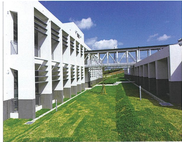
外観（C棟－ハブ棟間渡り廊下）
