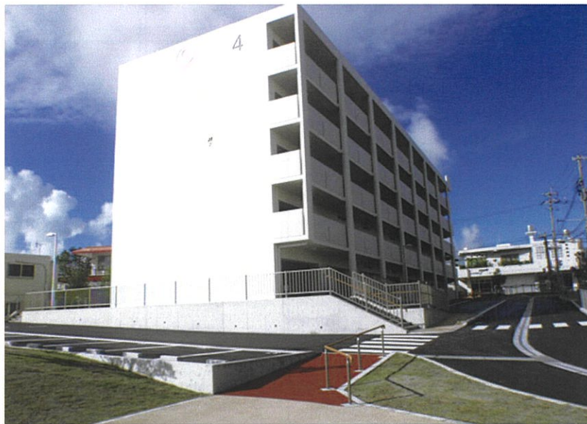
建物外観（4号棟）
