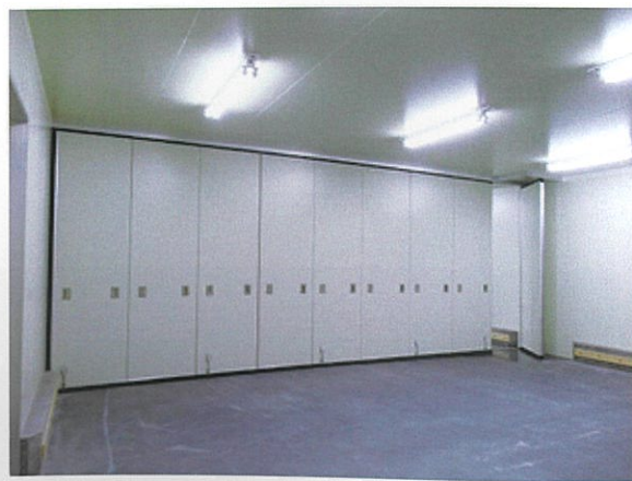
A棟内観 可動断熱間仕切り
