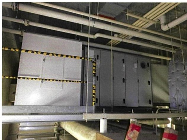
2階機械室空調ダクト取替後
