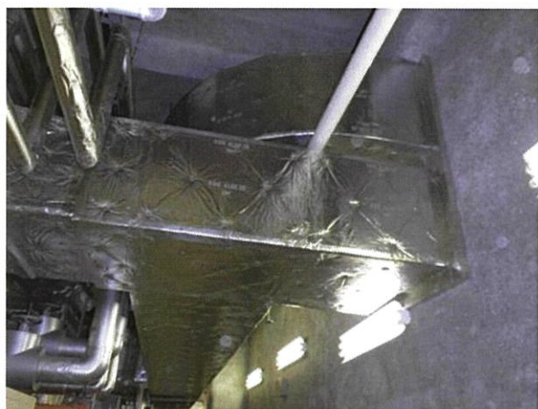
3階機械室ダクト取替後
