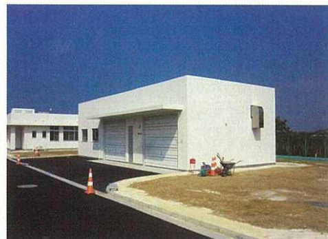
船舶資材倉庫
