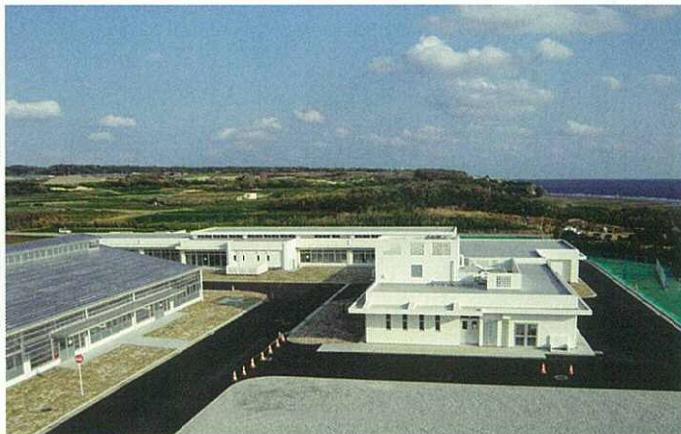
本館(西側外観)
