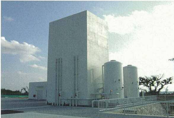
取水貯水棟(海水ろ過)
