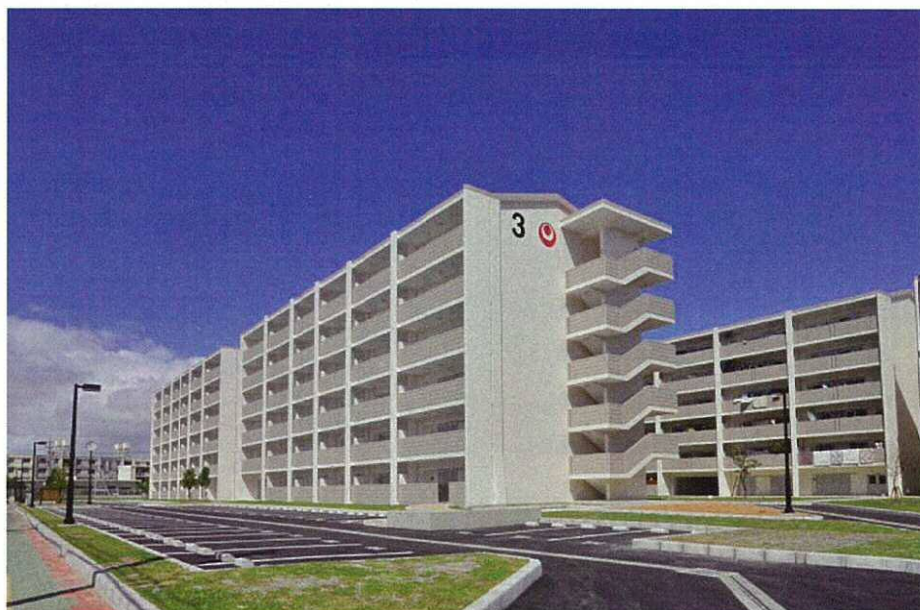
県営泡瀬団地新築工事（沖縄市）
