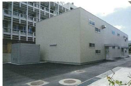
倉庫棟東側外観
