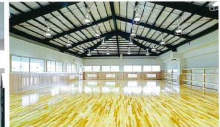
屋内運動場：武道場内部
