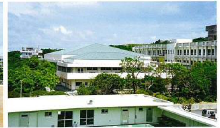
屋内運動場・水泳プール棟全景
