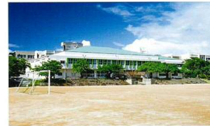
運動場より屋内運動場全景
