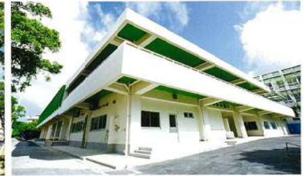
屋内運動場昇降口付近
