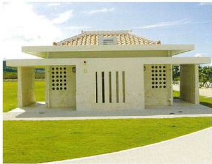
緑地東Ⅵ トイレ外観写真
