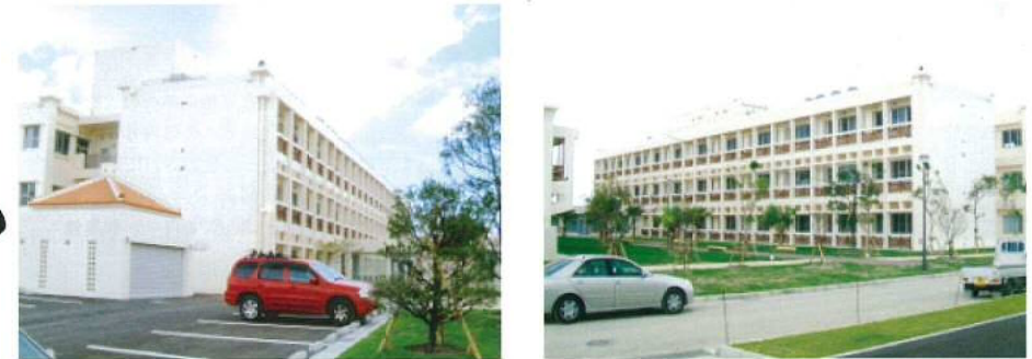
研究棟（建築1工区）
