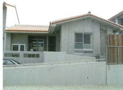
厨房棟へのスロープ
