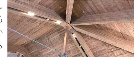
CLT 屋根表し事例
