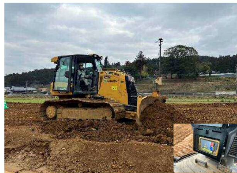
■ICT機械（MCブル）の施工状況の見学
