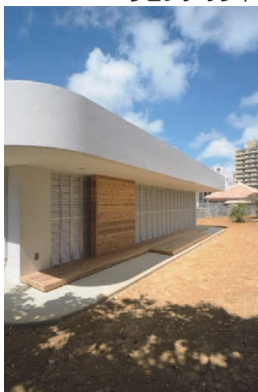
南面の開口部は、ルーバー戸による通風計画がなされている。
