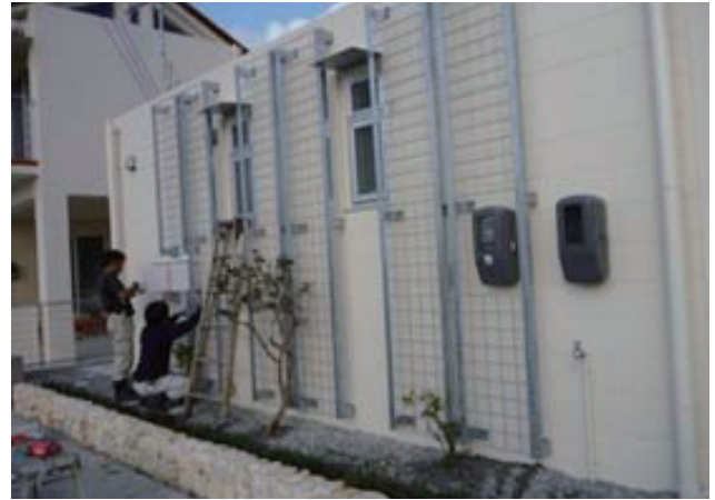
西側の壁面緑化による遮熱
