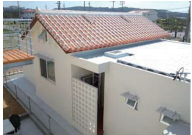
リビングの木造小屋組み工事
