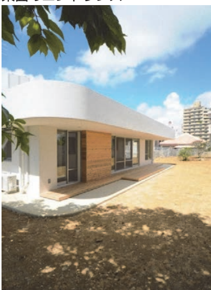
南面の開口部は、ルーバー戸による通風計画がなされている。
