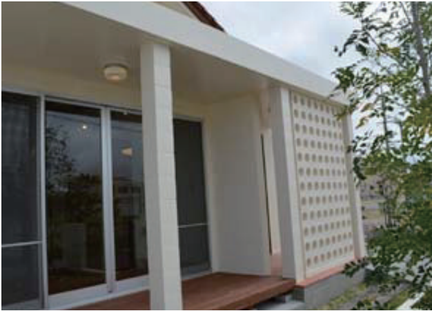
南側の大きな開口と遮熱ブロック
