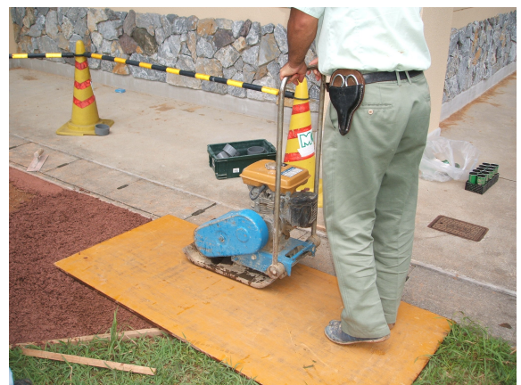
写真-3 締固め施工状況
