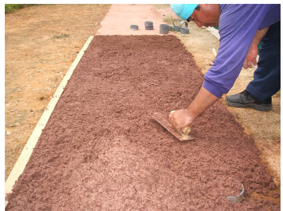
写真-2 敷き均しめ施工状況
