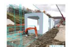
掘削作業時にARと比較
