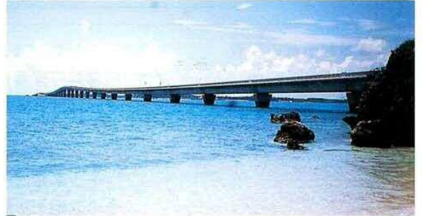
●橋の全体のシルエットは水平線との関係を重視する。 (池間大橋)
