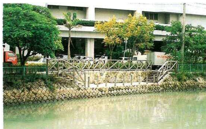
● 都市の河川を親しみのある水辺空間として整備している。 (那覇市、久茂地)
