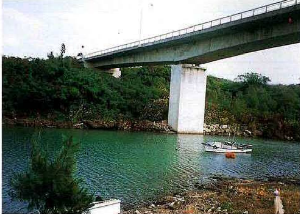
●橋脚のデザイン、工法に配慮し、周辺の自然改変を最小に抑制している。 (具志頭村)
