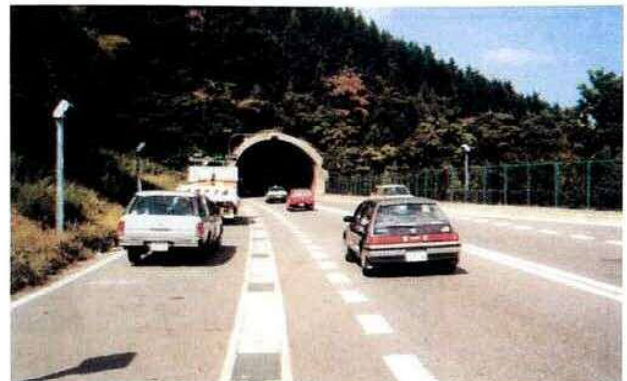
●ポータル法面を植生回復させて人工物を極力減らしている。
