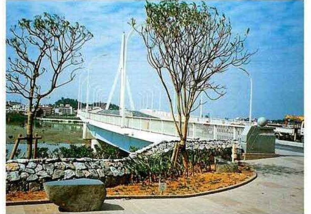
●シボリックな橋梁の眺望スポットとして橋詰広場を整備する。 (とよみ大橋)
