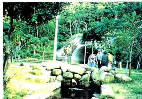
●自然域に抜けるトンネルの坑口部はコンクリートにまとめ、自然になじむポットアップ整備を行っている。 (石垣島)
