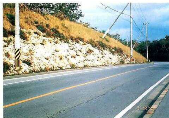
●法面傾斜を緩やかにし、擁壁に自然石を用いることで自然な仕上がりとなっている。 (名護市)
