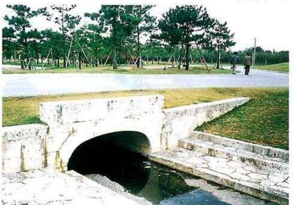
● 石造橋に琉球石灰岩を採用し、伝統の三心円アーチをデザインすることで沖縄らしい景観要素となっている。
