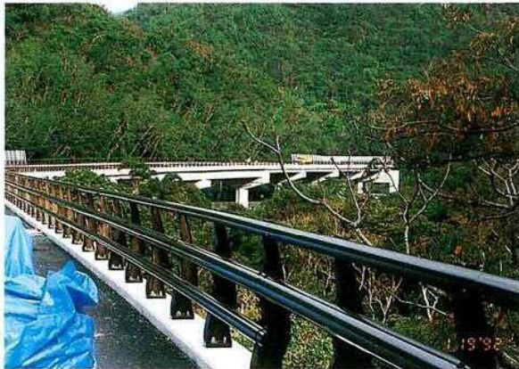
●地形に沿った線形により、自然改変を最小限に抑制している。 (名護市、国道329号)
