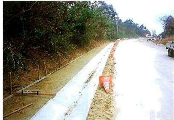
●皿形、V字側溝等の採用により、小動物の移動の障害を軽減している。 (西表島)
