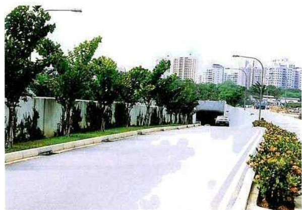
●地下トンネルの導入部の修景により、緑豊かな景観を形成している。 (シガポール)
