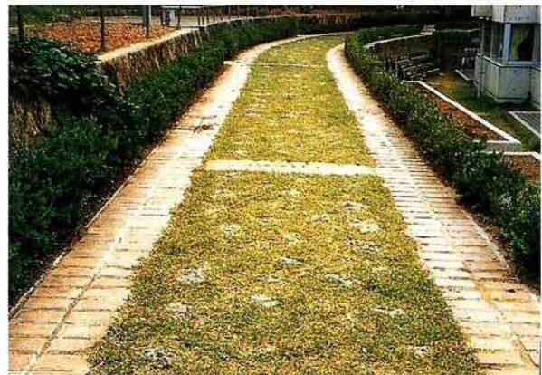
●舗装形式を工夫し、雨水の浸透を促進し、かつ緑地を形成している。 (那覇市、首里)
