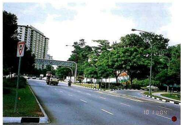
●ランプにおいて見通しと安全を確保しながら、積極的緑化を図っている。 (シガポール)
